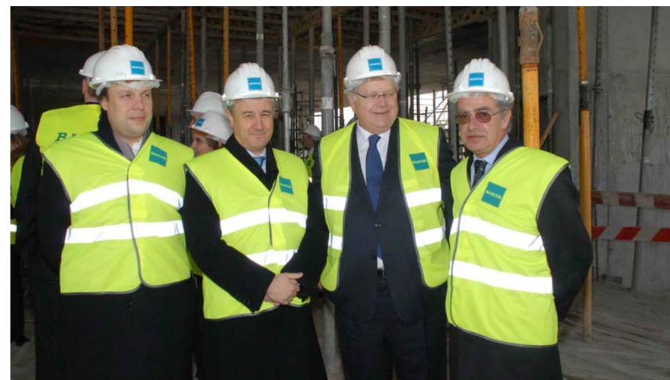
Gonçalo Gonçalves, Rui Rio, Lino Ferreira e João Luís Rozeira numa visita às obras da infra-estrutura
